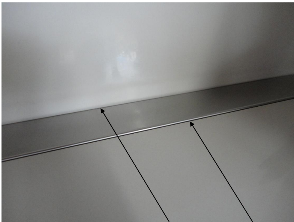
Vazão do Ralo Linear nas frestas de 3 mm da frente e de trás
